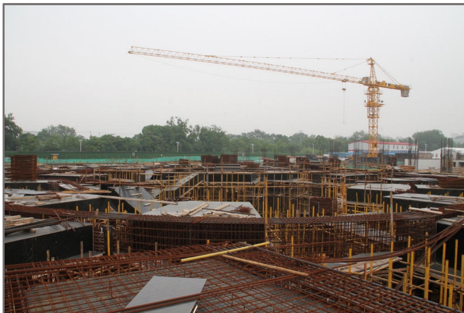
Die Baustelle der deutsch-französischen Schule steht still, weil der Unternehmer die Arbeiten eingestellt hat (Foto: Kai Breulmann)
